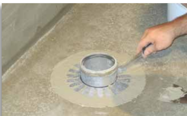
3. potapanje elastičnih traka u još svjež nanos hidroizolacijske mase. Trake prethodno izrežemo do polovice koja je označena sa crnom linijom
