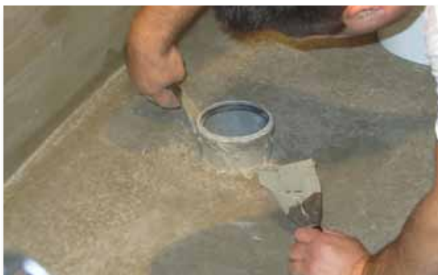
2. nanošenje HIDROZOLA Elastik uz pomoć molerske lopatice na prethodno nanešen 1. sloj i na cijev
