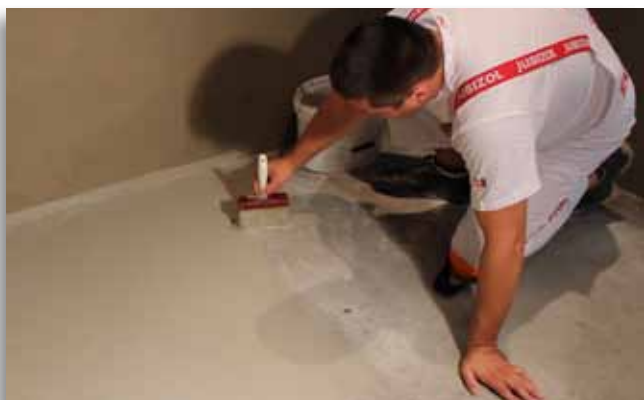
1. nanošenje 1. sloja uz pomoć veće četke
