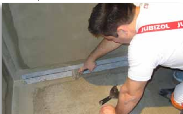
5. potapanje elastične linijske trake u sloj HIDROZOLA ELASTIK nanesenog na pod i zid.
