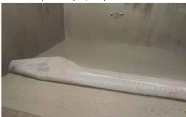
6. potapanje mrežice (samo na horizontalnim površinama) u 2. sloj, koji je nanešen s pomoću mistrije
