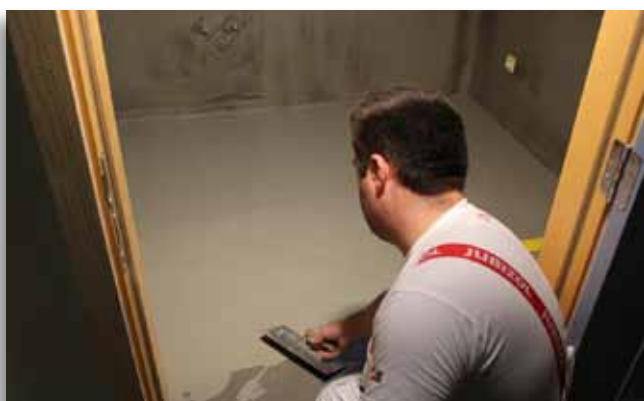
7. nanošenje zadnjeg 3. sloja HIDROZOLA ELASTIK sa mistrijom
