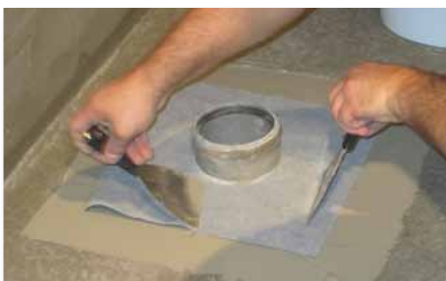
4. ponovno nanošenje HIDROZOLA ELASTIK na horizontalnu površinu uz potapanje manžetne u koju smo prethodno urezali otvor veličine prečnika cijevi/proboja.
